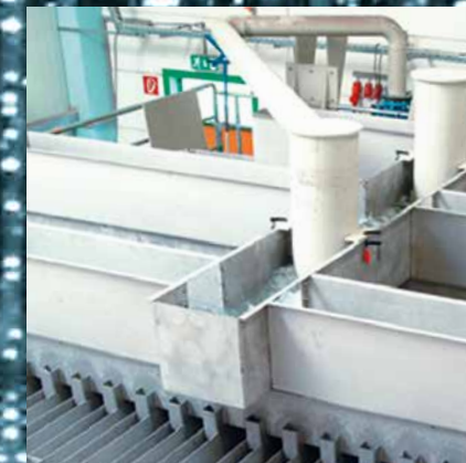
Überprüfung eines Rinnenverteilers
